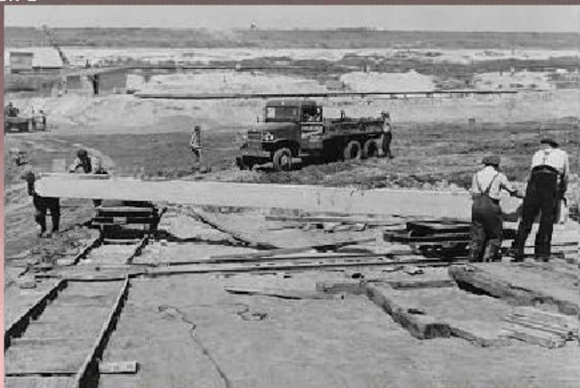
01-07-1953 Bouw gemaal 'Colijn' , transport van de eerste betonpaal
